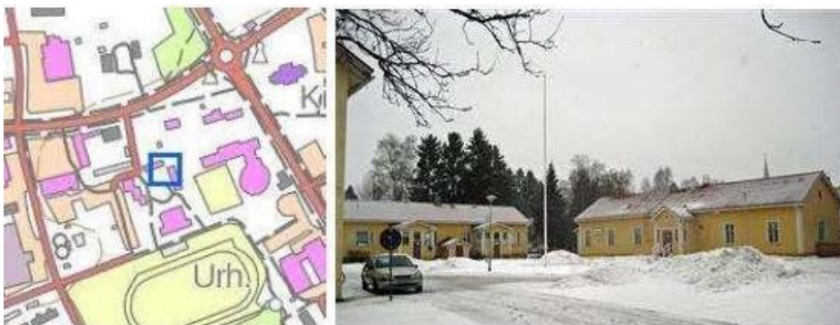
Kuva. Hirvelä ja entinen kunnantalo. Pohjois-Pohjanmaan rakennettu kulttuuriympäristö 2015.
