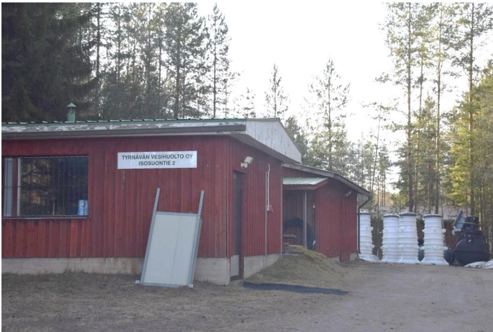
Kuva. Tyrnävän vesihuollon kiinteistö Isosuontien ja Kirkkotien/Kylmäläntien risteyksessä.
