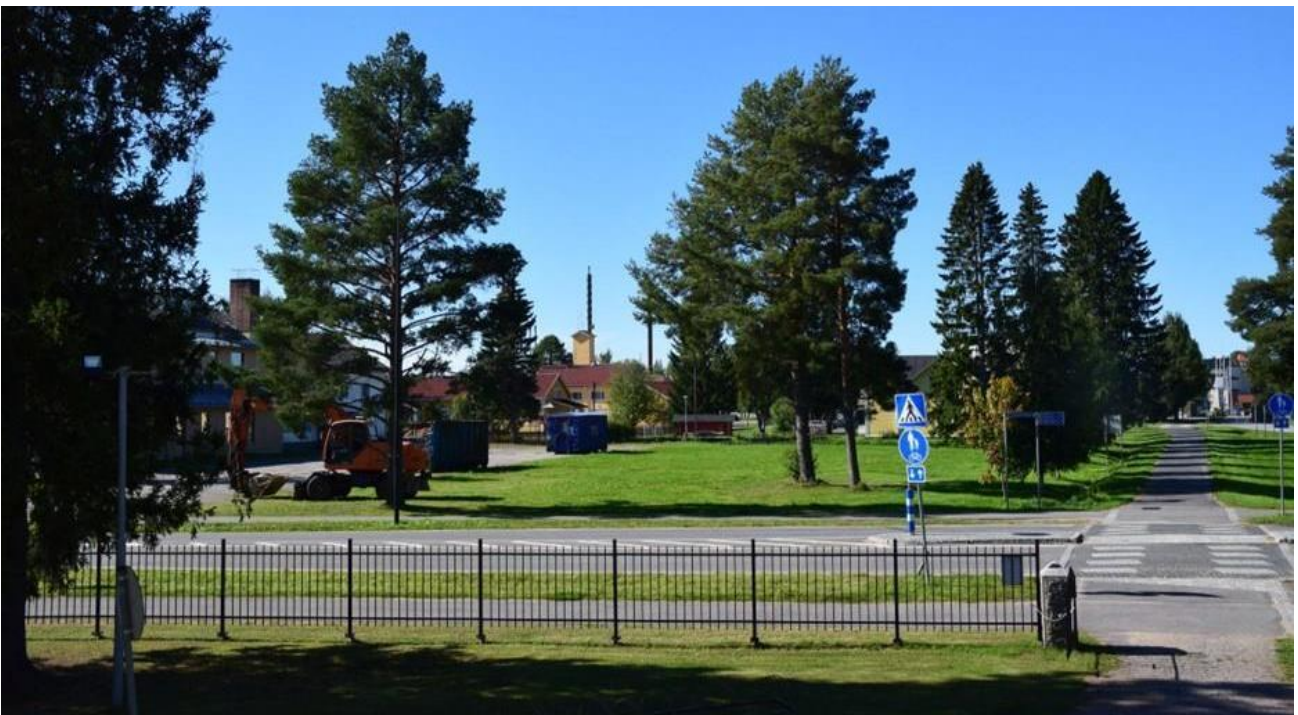
Kuva. Kirkkomännikön 1970-luvulla rakennettu ruokalaosa on purettu kesällä 2023. KVR-kilpailutettu päiväkotirakennus rakennetaan pyöreän osan jatkoksi. Uusi päiväkotirakennus rakentuu Koivulan seinälinjaa pitkin kuvassa näkyvän reunimmaisen männyn tienoille, josta nurkka kääntyy kohti kaivinkonetta. Siniset kontit osoittavat rakennusmassan leveyttä Kirkkotien suunnassa.
