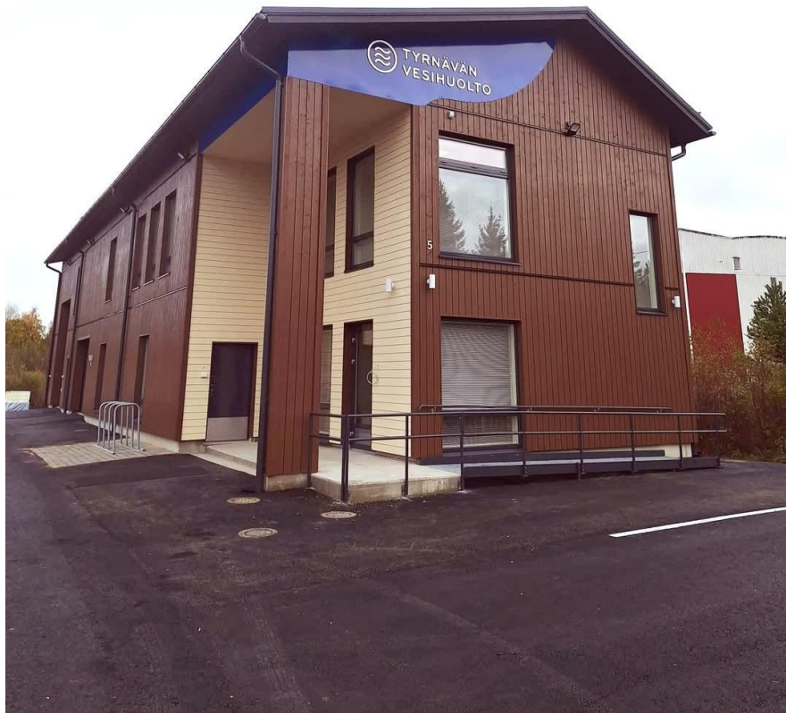
Tyrnävän Vesihuollon uudet tilat valmistuivat Tehtaantielle. Kuva: Paavo Kuusela.
