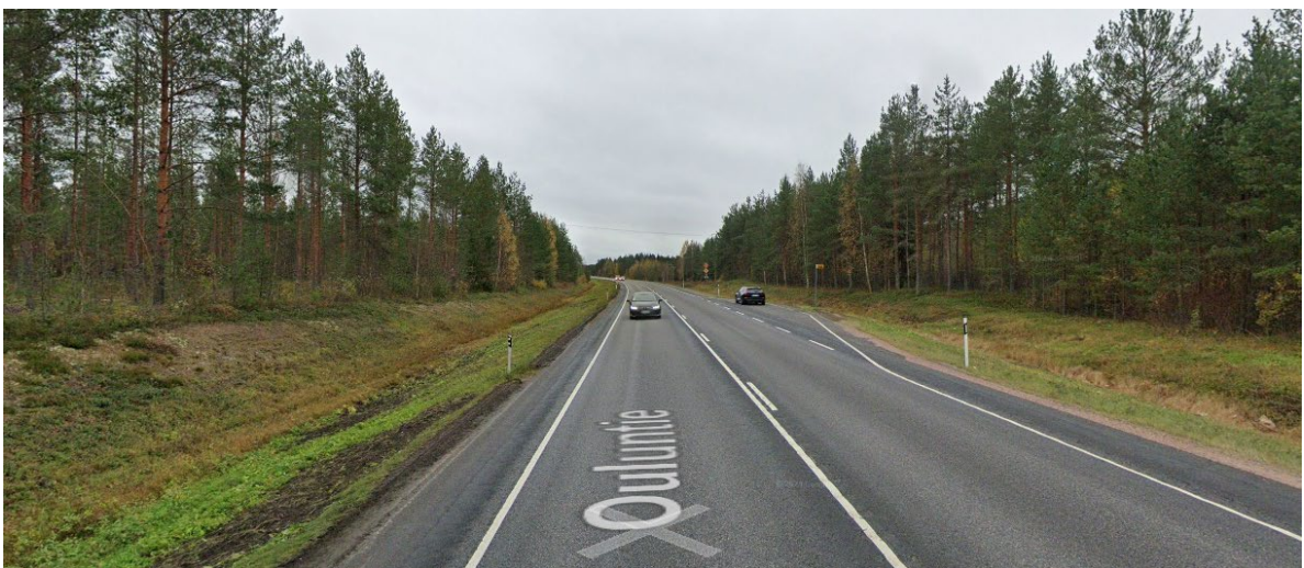
Kuva 3: Näkymä valtatie 4:ltä etelään Haurukylän liittymän kohdalta.
