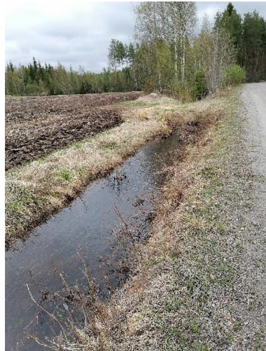
Kolmikannan louhoksen tyhjennyspumppaus. Veden virtaus Kivitiel pelt -ojassa 17.5.2023, kuva Hannu Vehkaperä
