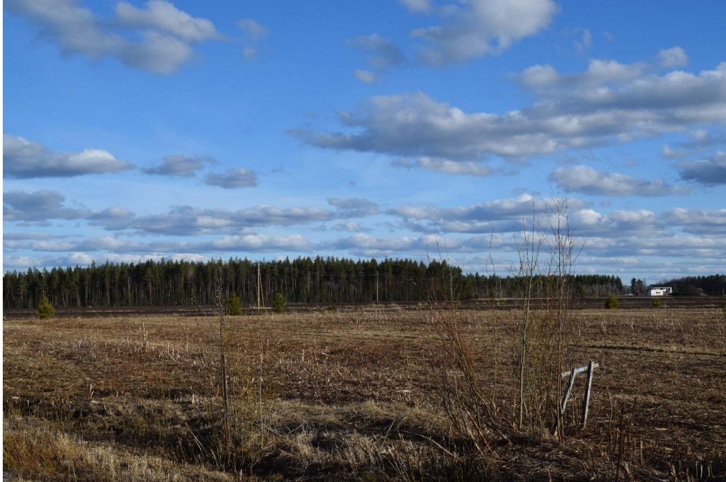
Kuva. Avoimella peltoalueella näkyvä ilmajohto on osaksi kaivettu maahan. Kuva on otettu Saverikko -kadun keskivaiheilta kohti Itää.
