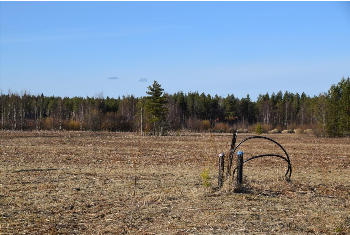
Kuva. Saverikko -kadun toteutettua kunnallistekniikkaa sen länsipuolella.
